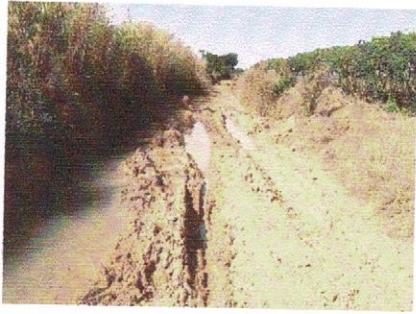
-ซ่อมแซมถนน สายนิคมสหกรณ์ข้ามทะเลสาบ ซอย 8 หมู่ที่ 6 บ้านโคกหินเหล็กไฟ
